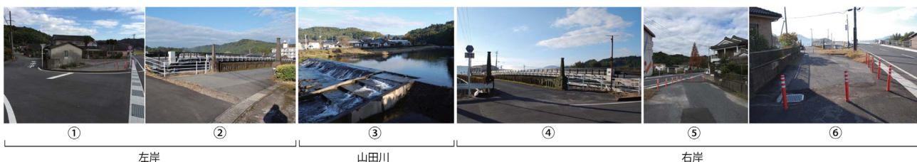
図-7 新設された山田橋を含む旧山田橋の周辺状況
