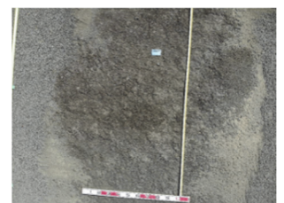
図-4 スケールの設置
