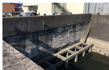
写真-2 木材港水門(下流側)
