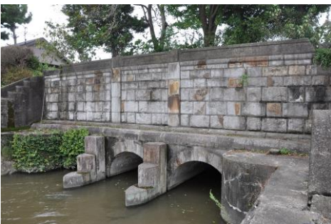
写真-10 群築二番町樋門
