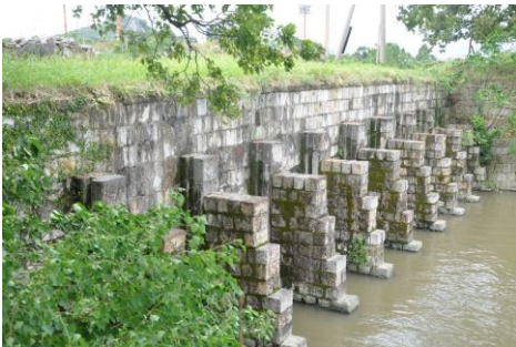
写真-9 群築三番町樋門
