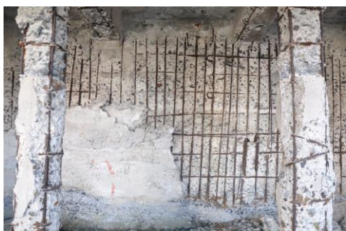
写真-3 水門内部の様子
