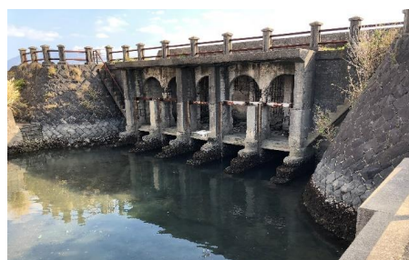
写真-1 木材港水門(上流側)
