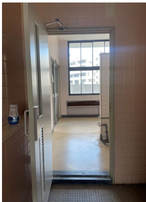
写真-7 2号館1階女子便所
