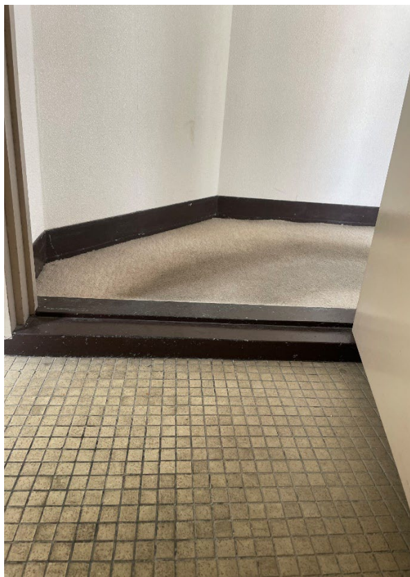
写真-13 9号館1階トイレ入口
