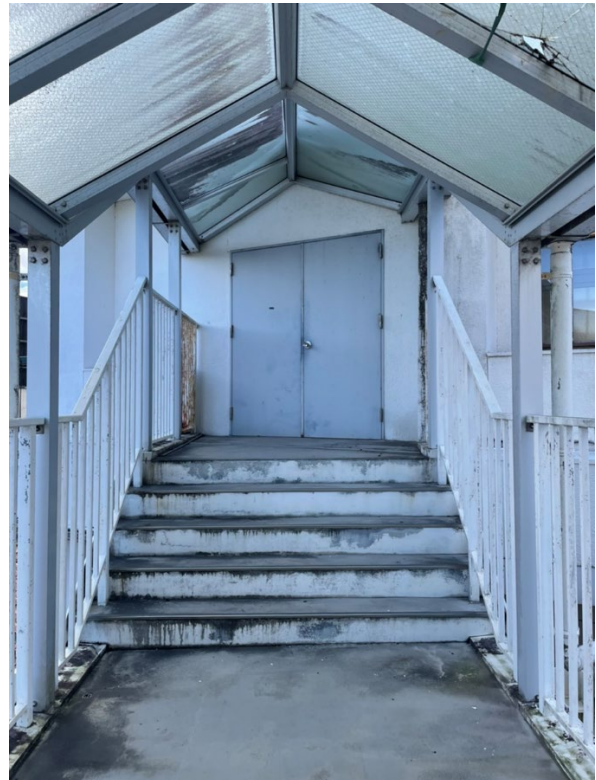
写真-11 渡り廊下(1号館と2号館の間)
