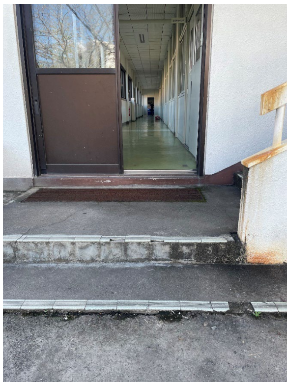
写真-14 4号館1階西側出入口
