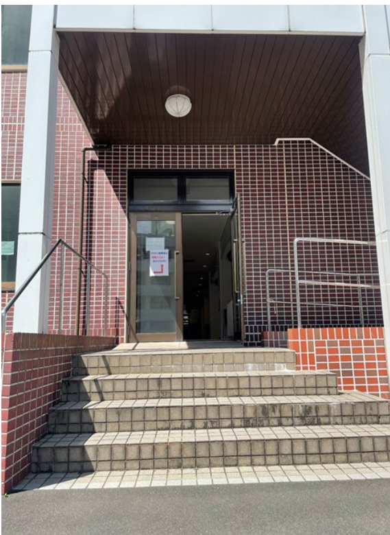
写真-10 厚生会館1階屋外階段
