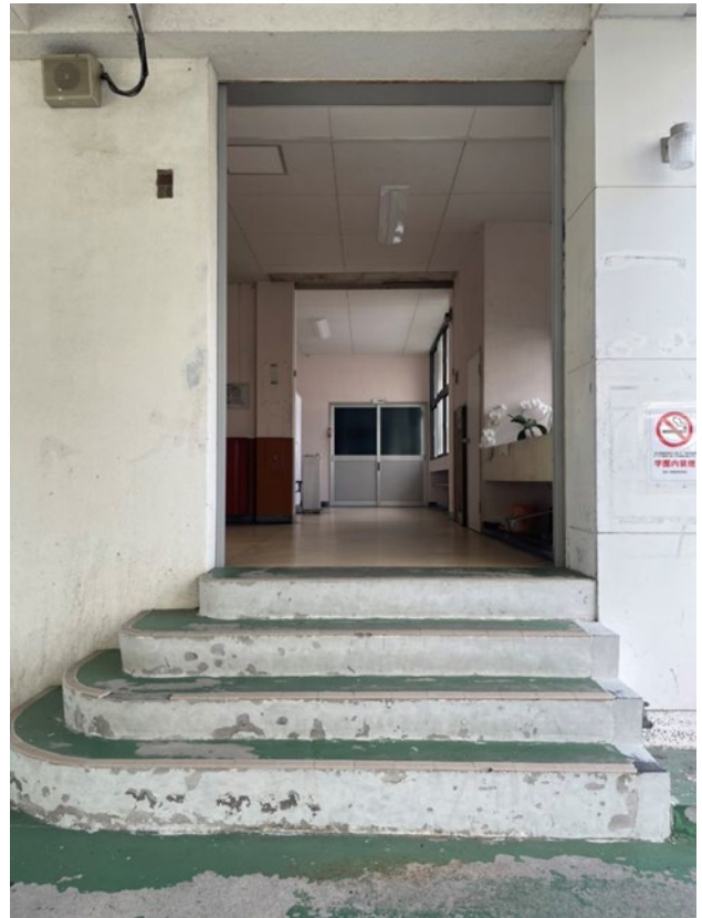
写真-3 2号館1階南側出入口
