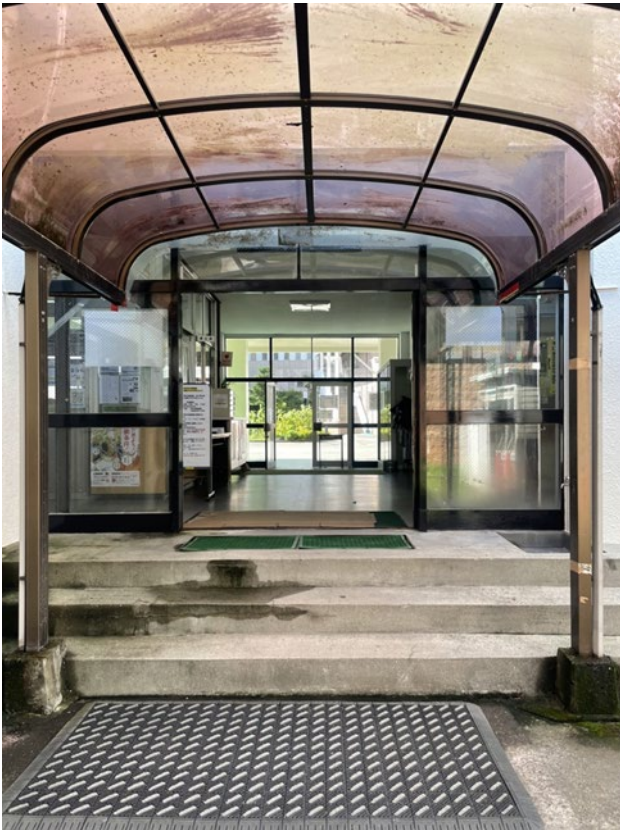
写真-1 1号館裏口
