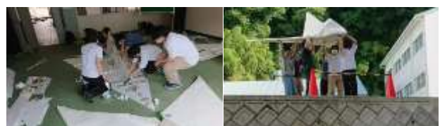
図 14.強度補強改修と飛行試験
