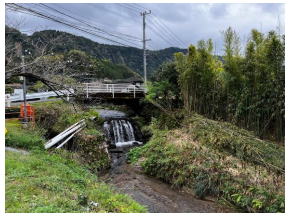
写真-4 左岸側の竹藪伐採後
