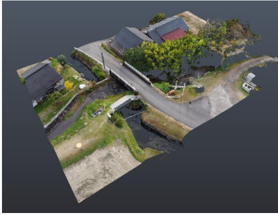
図-1 平熊の石洗越の点群データ
