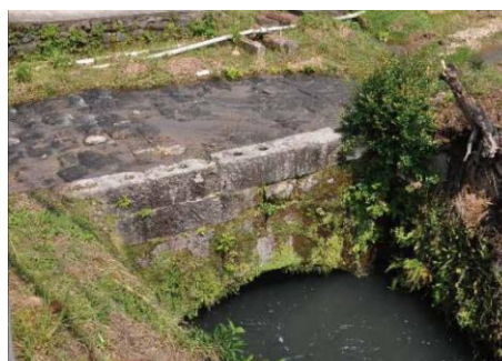
写真-1 石造アーチ橋部分
