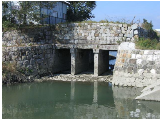
写真-4 江中樋(大鞘樋門群のひとつ)
