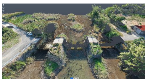
図-2 橋梁部分除去後
