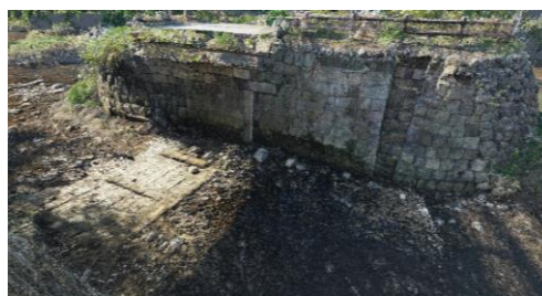
図-3 樋管周辺の状況 (橋梁部除去後)
