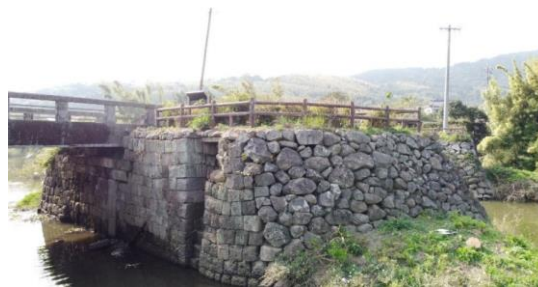
写真-1 島津樋門跡
