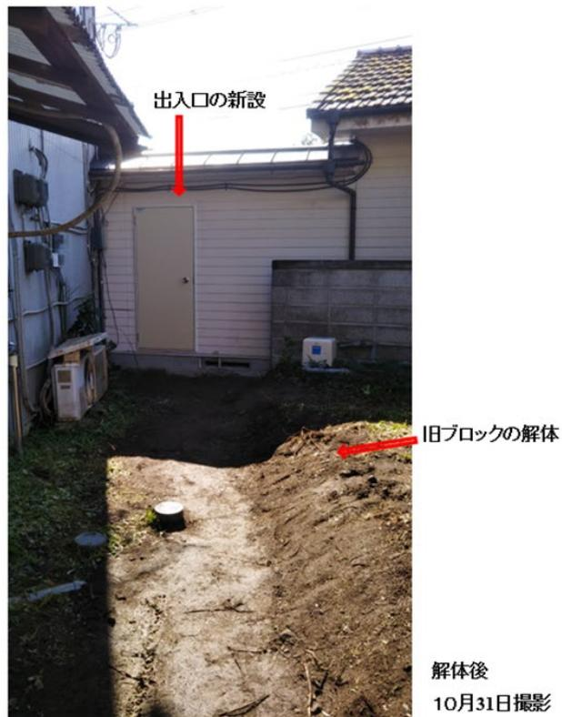
ブロック塀の解体：ユンボにアタッチメントを付けて、ブロックを挟みながら解体した。ブロックの解体くずや鉄筋も処理してもらい最後に床の整地を実施してもらう工事を依頼した。また、外部ドアの取付けを専門会社に依頼した。
