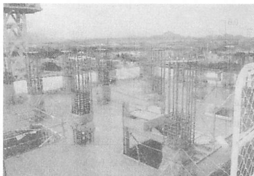
写真-6 水平コンクリートの養生風景
