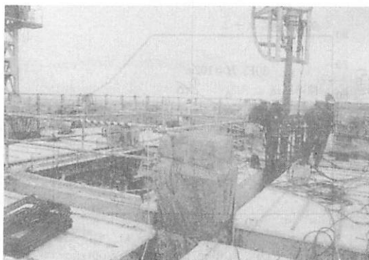
写真-5 柱天端養生風景
