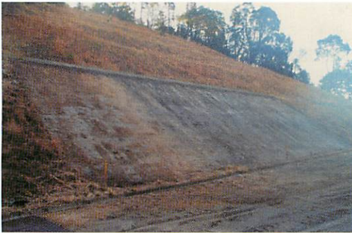
図3・1 基面処理工後の法面(施工日平成2月8日)
