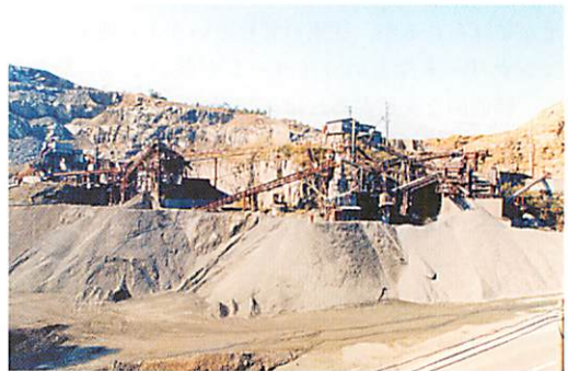
写真2 再生骨材製造プラント(Y碎石KK)
