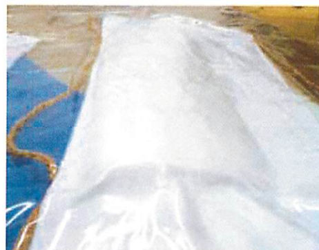
図7 大気圧による圧着（上面）
