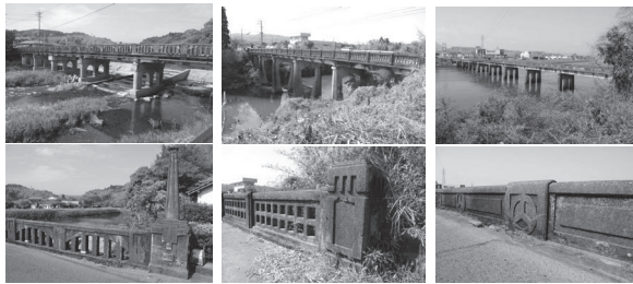
① 山田橋 ② 永瀬橋 ③ 始良橋
