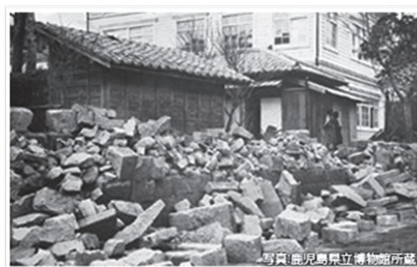
写真1 鹿児島市内の被害状況
