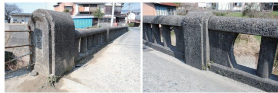
図-9 曲線を多用した白水谷橋のデザイン 親柱(左)と中柱・高欄(右)
