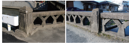
図-8 直線を多用した毛来橋のデザイン 親柱(左)と中柱・高欄(右)
