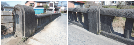
写真-2 曲線を多用した白水谷橋のデザイン 親柱（左）、中柱（右）と円柱型の高欄
