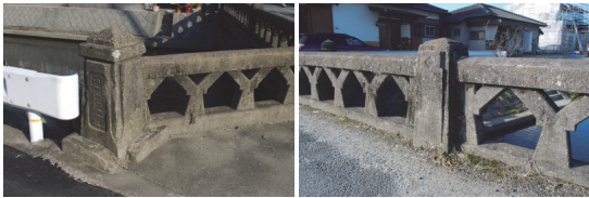
写真-1 直線を多用した毛来橋のデザイン 親柱（左）、中柱（右）とY字型の高欄
