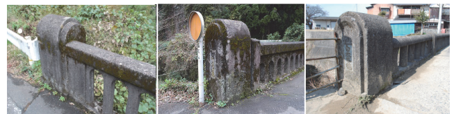
写真-3 左から⑤分田橋, ⑥馬場橋, ⑦白水谷橋
