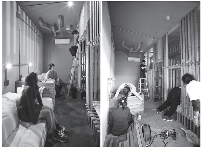
図2 小断面杉材を用いたホテル客室の家具、写真：川越亮（制作過程の写真を除く）
