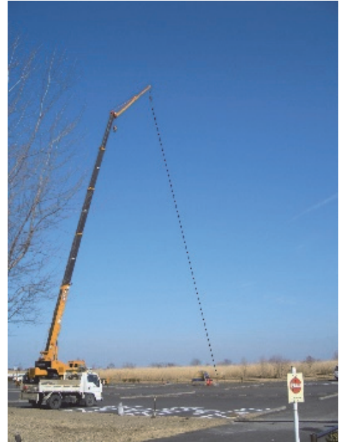
写真2 クレーンアンテナ
