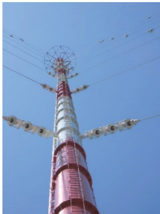
写真 1 基部絶縁円管柱
