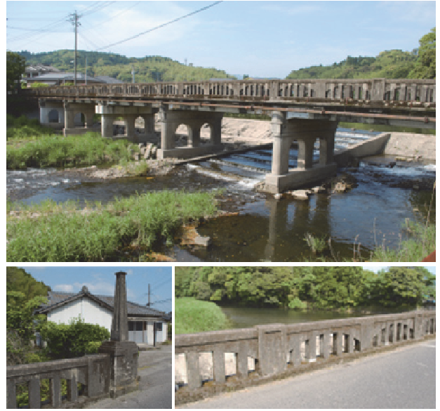
写真-1 山田橋 (昭和4年竣工 上:全景, 下:橋上景)
