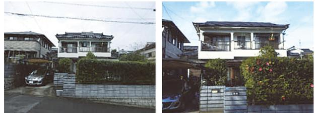
写真 7 化粧スレート屋根への葺き替え
